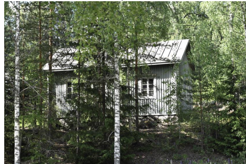
Kuva: Koulutalon kanssa samassa pihapiirissä on pienehkö harjakattoinen, lautavuorattu hirsitalo, joka saattaa olla rakennettu koulun käsityöluokaksi kohta koulutalon valmistumisen jälkeen, 1874 - 1875.
