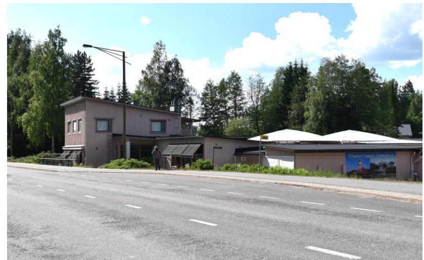
Kuva: Mäntyharjuntien korkeusasema suhteessa ympäröivään maanpintaan on tien kunnostustöiden seurauksena muuttunut, tien pinta on nykyään selvästi ylempänä kuin vanhan osuuskaupan rakentamisen aikaan 1930-luvulla.
