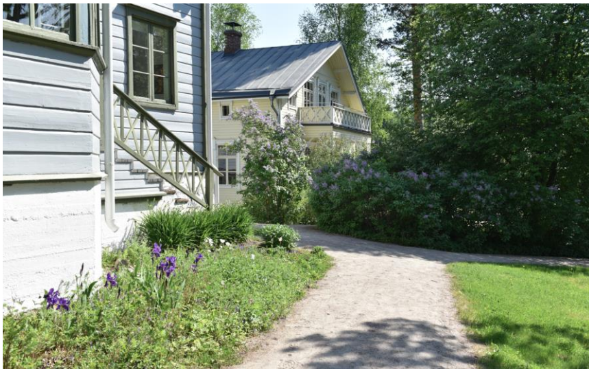
Kuva: Domanderin alueella pihapiirien hoitotapa on harmoniassa vanhan rakennuskannan kanssa. Apteekki-postitalo on kunnostettu 2003.
