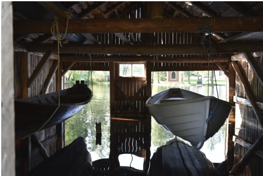
Kuva: Kahden veneen hirsikehikorakenteinen lautaseinäinen venevaja. Rakenteet pitkälti uusittu, mutta vanhaan malliin.
