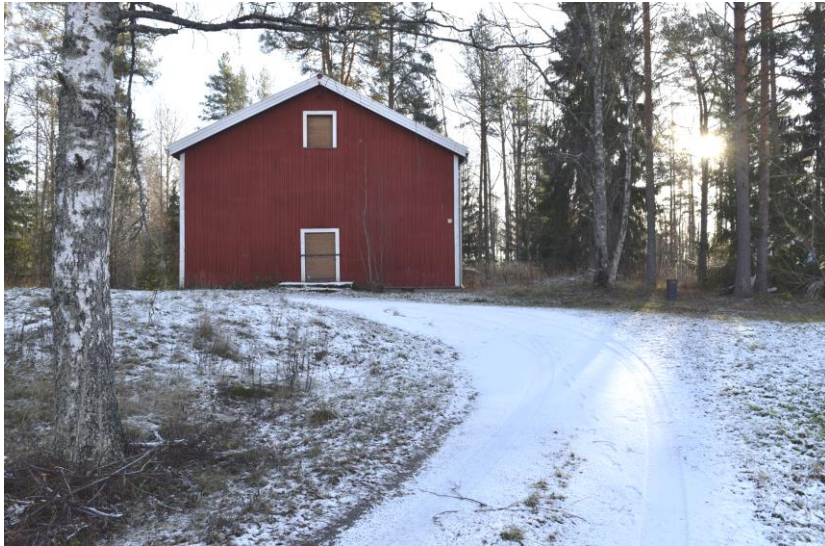
Kuva: Viljamakasiini (11). Kooltaan samankokoiset ja hirsirungoltaan vuoratut ja punaiseksi maalatut pitäjänmakasiinit sijaitsevat noin puolen kilometrin etäisyydellä toisistaan. Makasiinintien viljavarasto on yksittäisrakennus, mutta Arkontien viljavarastoon on liitetty myöhemmin kylkiäinen.
