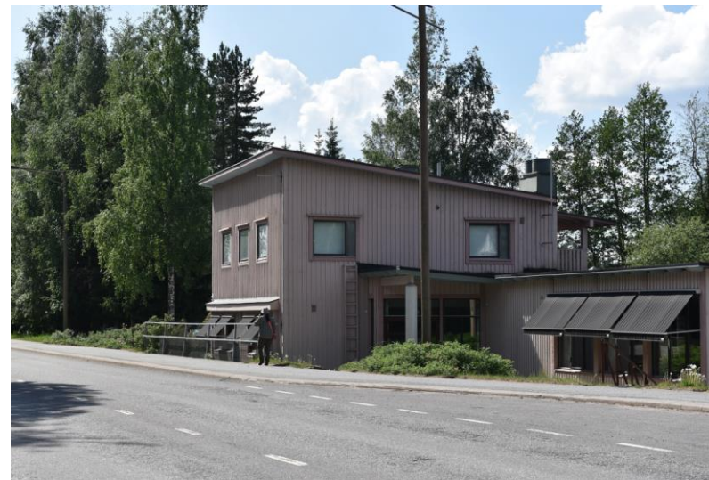
Kuva: Mäntyharjun Osuuskaupan kirkonkylän myymälä sulki ovensa 1971. Kauppatalo peruskorjattiin ja laajennettiin ravintola Kesäheinäksi 2001–02. Vanhaan osaan on uusittu ikkunat uudella karmijaolla.
