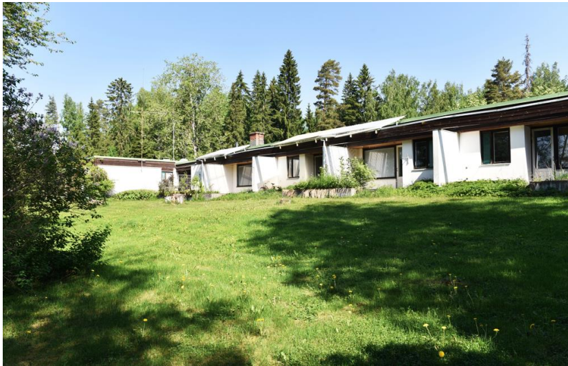
Kuva: Meltan pappilalle myönnettiin rakennuslupa 1967. Suunnittelijana oli helsinkiläinen Arkkitehtitoimisto Leo Tenhunen. Talojen pystyrunko on kevytbetonia ja puuta, rakennustapana puolieleменти.
