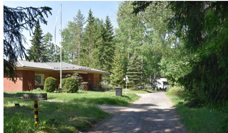
Kuva: Tervaniementie 19: Omakotitalo, myönnetty rakennuslupa 1973. Tehty kattomuodon muutos tasakatosta aumakatoksi 1990-luvulla.
