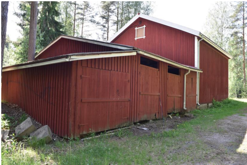
Kuva: Viljamakasiini (11). Kooltaan samankokoiset ja hirsirungoltaan vuoratut ja punaiseksi maalatut pitäjänmakasiinit sijaitsevat noin puolen kilometrin etäisyydellä toisistaan. Makasiinintien viljavarasto on yksittäisrakennus, mutta Arkontien viljavarastoon on liitetty myöhemmin kylkiäinen.
