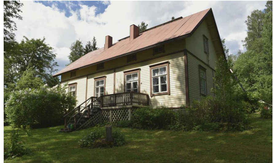
Kuva: Sirolassa (5) on jyrkkäharjainen, lohkopintaisille harkkokiville perustettu hirsitalo, jonka yläkerta on lautarakenteinen. Ikkunat vanhat sisään-ulosaukeavat. Tervaniementien puoleisessa fasadissa on vinkkeli ja sisäänvedetty kuisti.
