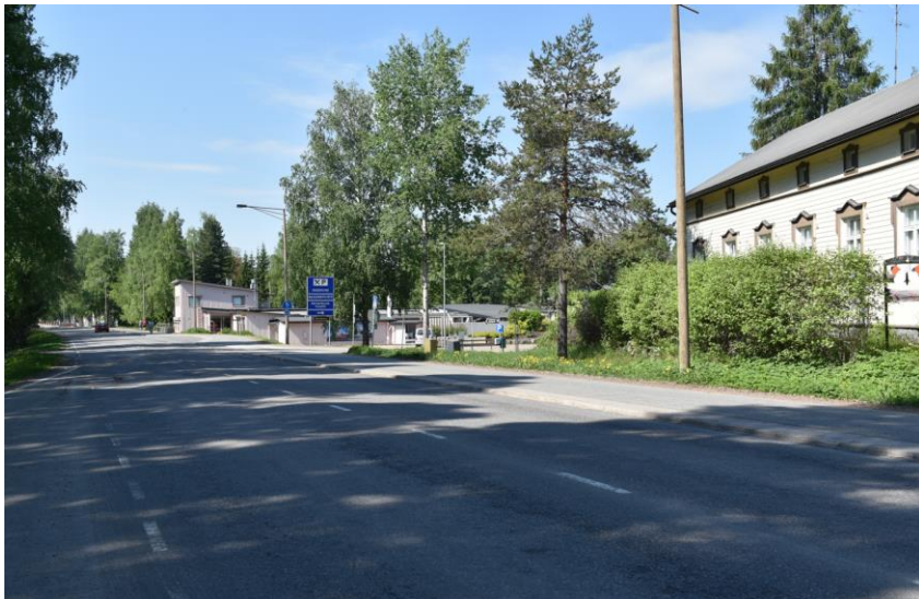
Kuva: Mäntyharjuntie on leveähkö ja entinen osuuskauppatalo on jäänyt korotetun tienpinnan alapuolelle.
