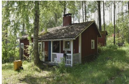
Kuvat: Metsälä. Talossa on laastilla vahvistettu luonnonkivijalka. Ikkunat ovat vanhat sisään-ulosaukeavat. Ulkoverhous ja kuisti tehtiin 50-luvun alussa.
