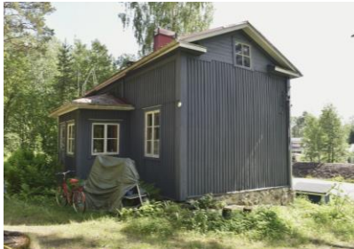
Kuvat: Metsälä. Talossa on laastilla vahvistettu luonnonkivijalka. Ikkunat ovat vanhat sisään-ulosaukeavat. Ulkoverhous ja kuisti tehtiin 50-luvun alussa.
