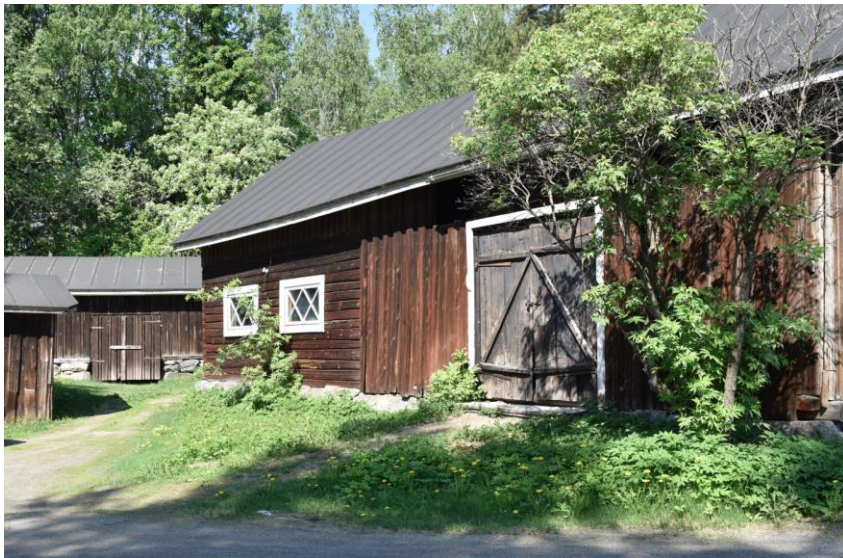
Kuva: Rakennusten välissä näkyy lampolan, kellarin ja vajoja käsittänyt rakennus. Etualalla on entinen karjasuoja (parin lehmän navetta, betonilattia).
